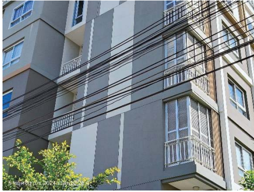
แผงอลูมิเนียมแบบบานเลื่อนป้องกันละอองน้ำ
