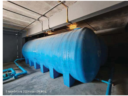
ถังเก็บน้ำดับเพลิงสำรองชั้นดาฟ้า
