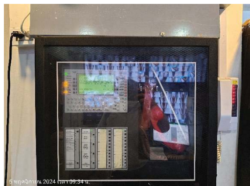
แผงควบคุมระบบแจ้งเหตุเพลิงไหม้ (Fire Alarm Control Panel ; FCP)
